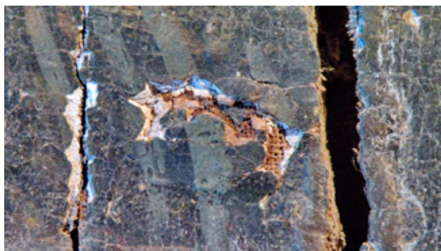
Сл. 36, 37 Прилепено платно на пукнатините и клиновите за амортизација (детали)
