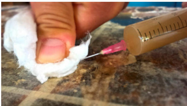
Сл. 50 Вбризгување на туткален раствор
