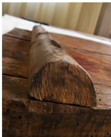
Сл. 35 Попречна пречка со неотстранета кора
