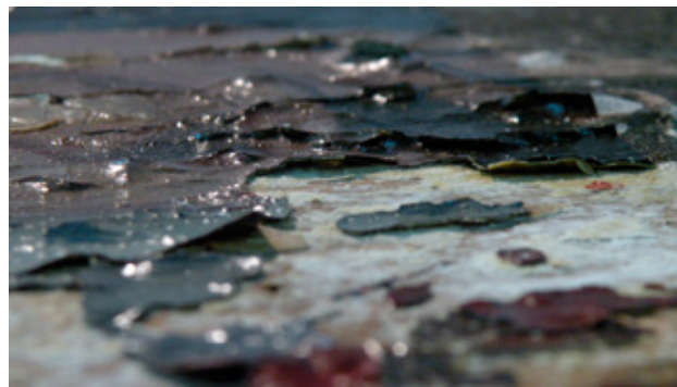
Сл. 25 Одвојување и отпаѓање на боениот слој, детали
